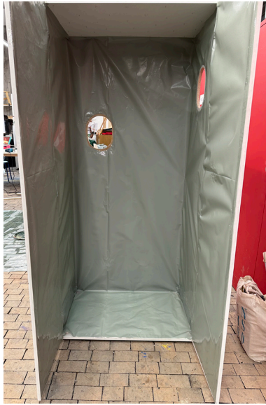
Abbildung 9 Auskleiden mit Folie
